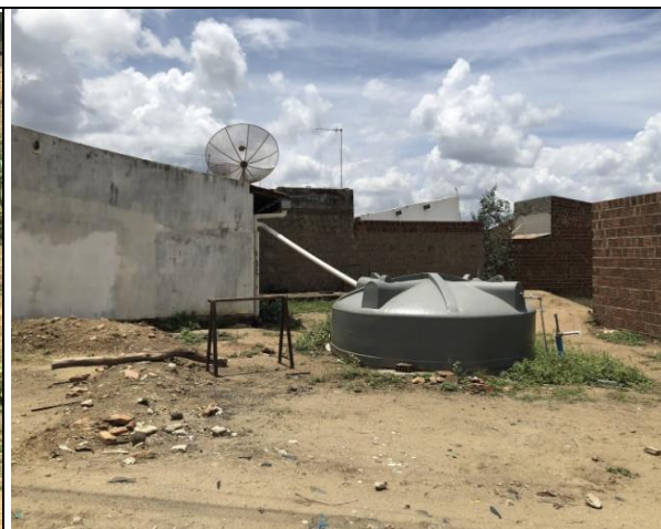
FOTO 02: Presença de grande quantidade de cisternas para captação de águas pluviais.
