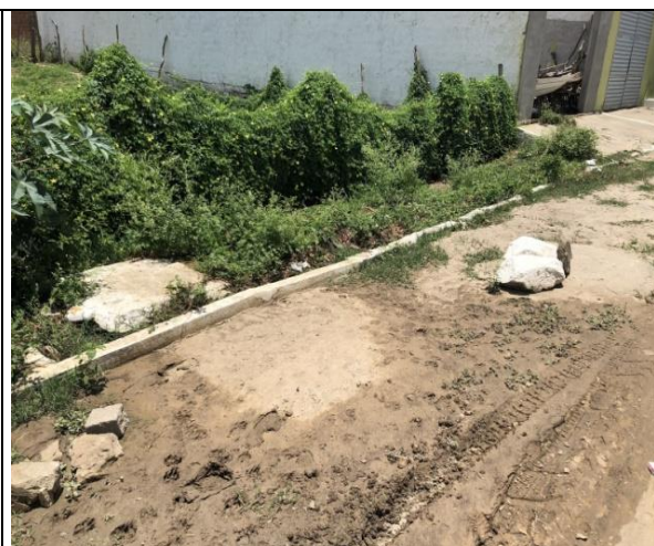
FOTO 06: Poços de Visita (PV's) construídos na rede.
