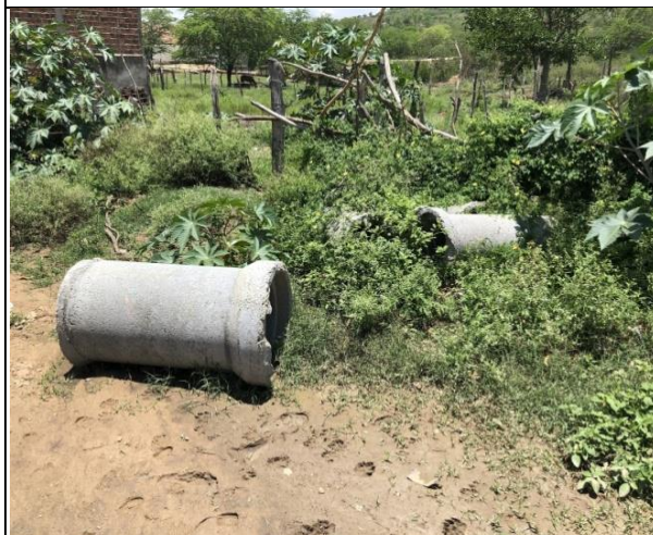
FOTO 07: Tubulação antiga da rede coletora de esgoto. Alguns trechos já foram substituídos por tubos de PVC.
